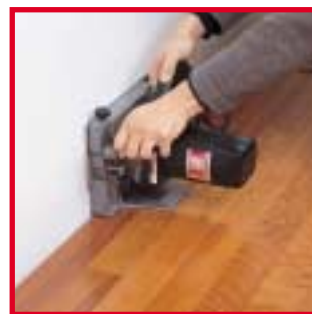
■ Rifilatura pavimento
