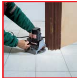
Jamb cutting Zuschneiden der Zargen
