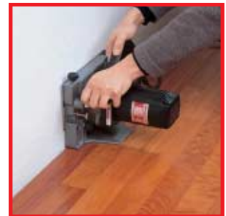
Floor trimming Fugenschneiden im Fußboden
